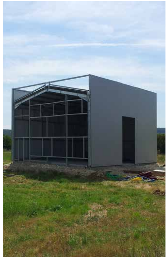
CONSTRUCTION D'UN BATIMENT POUR UNE SOCIETE D' E-COMMERCE
