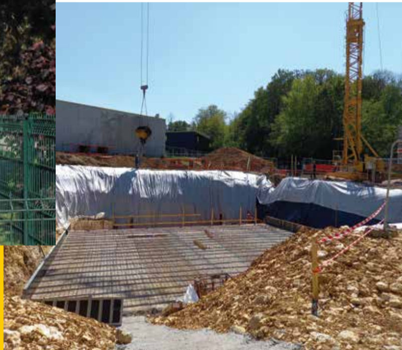
Réhabilitation de la station d'épuration de Beaucourt jusqu'à la mi-2022
