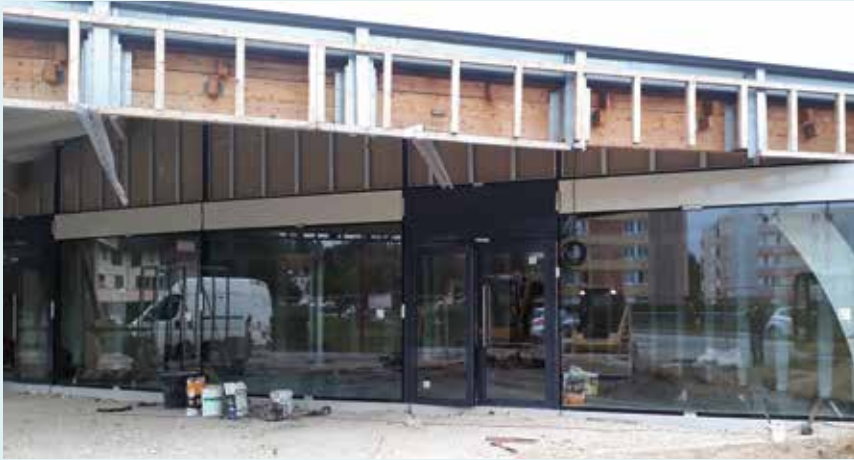
Le bâtiment de la ZAC de l'Allaine en plein travaux
